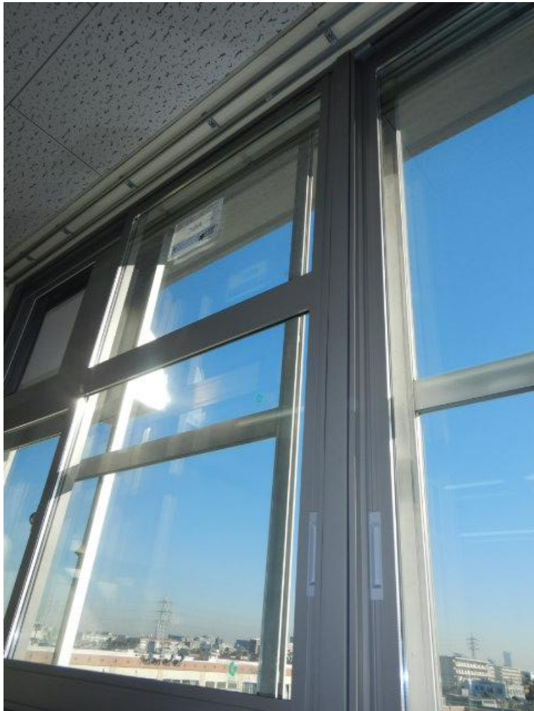
樹脂製内窓 複層ガラスLow-e t4+A10+強化ガラスt4
