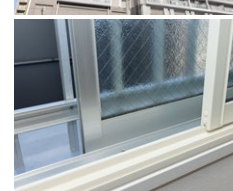
全住戸の内窓設置を実施
