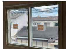
主居室の南側に内窓設置
