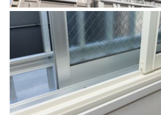
全住戸の内窓設置を実施
